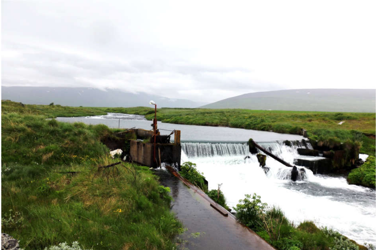
MYND 16 Stífla, fiskvegur, inntakspró og efsti hluti þrýstipípa virkjunar í Djúpa.
