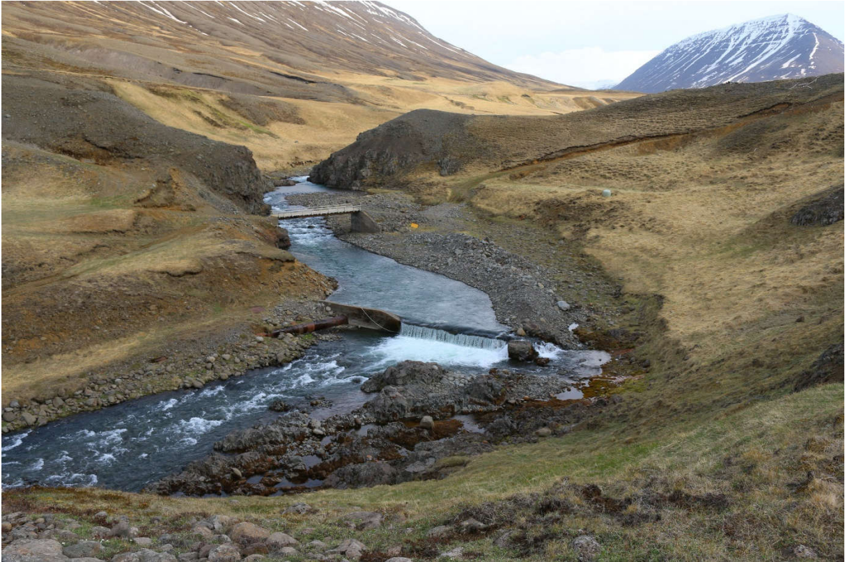
MYND 43 Stífla sem tilheyrir gamalli virkjun í Núpá, ofar sést í álitlegt stíflustæði nýrrar virkjunar.
