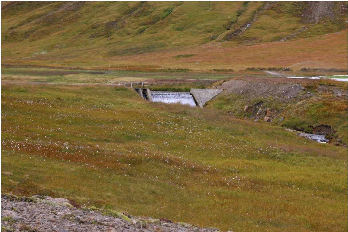
MYND 8 Núverandi stíflu- og inntaksmannvirki Garðsárvirkjunar.
