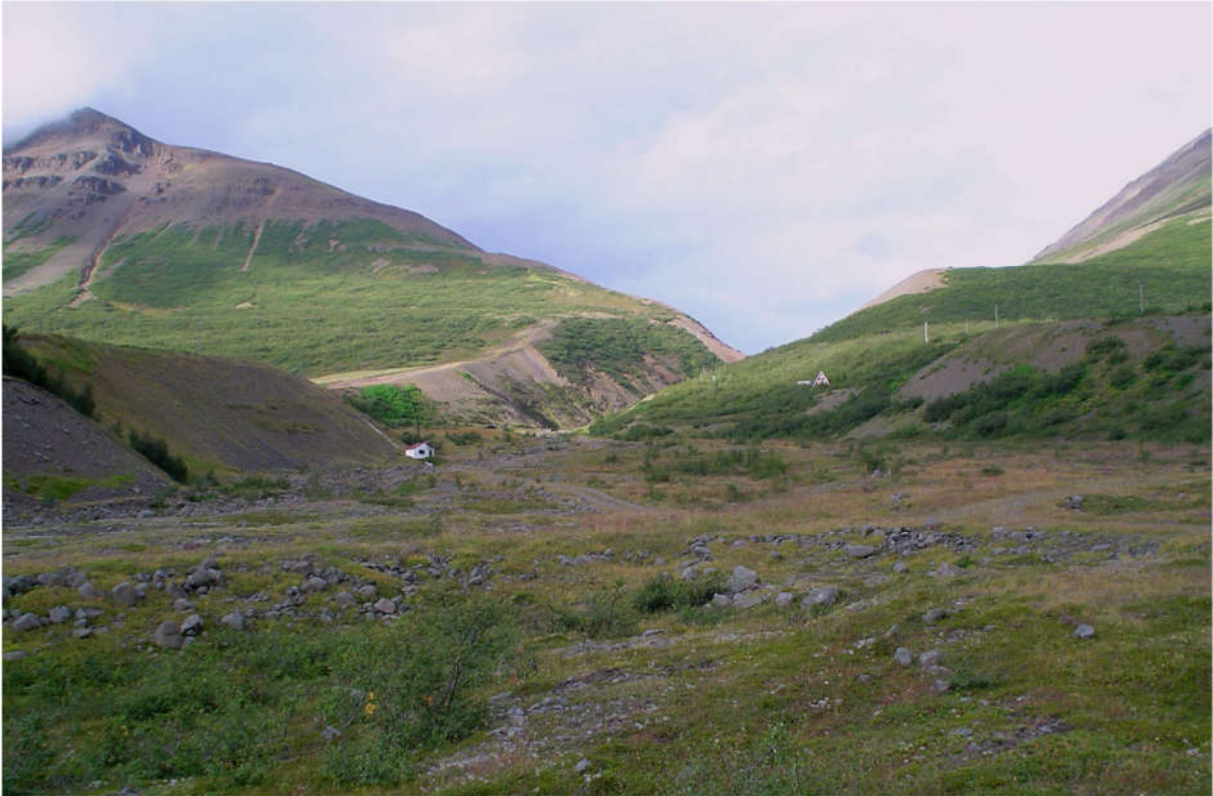
MYND 50 Gil Skarðsár og Skarðsdalur séð frá Þjóðvegi. Stöðvarhús núverandi virkjunar fyrir miðri mynd.
